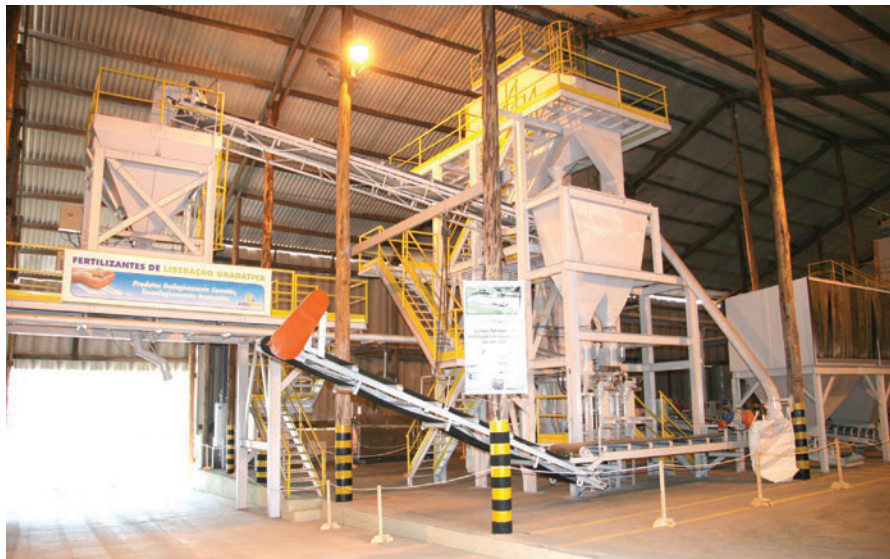
Vista parcial das instalações da Adhugas
