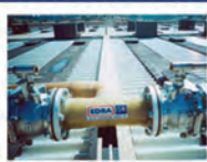
ETE de grande porte
